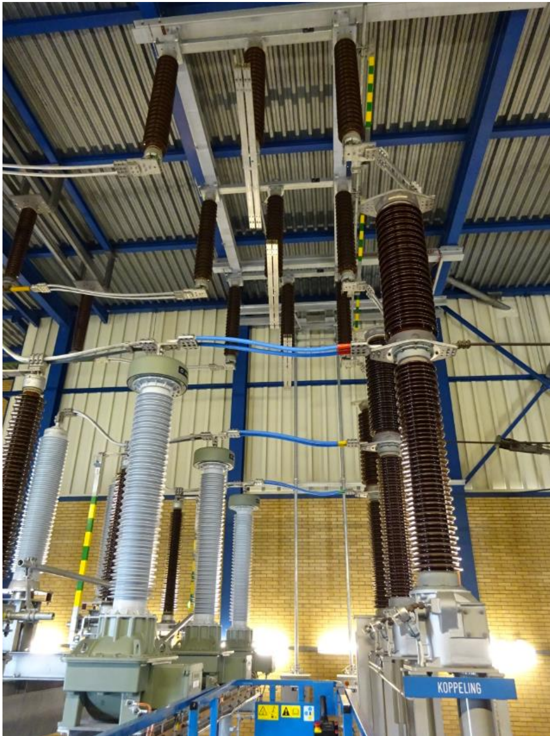
Foto 2: Aangebrachte flexibele noodgeleiders RTM wit gestoord.
