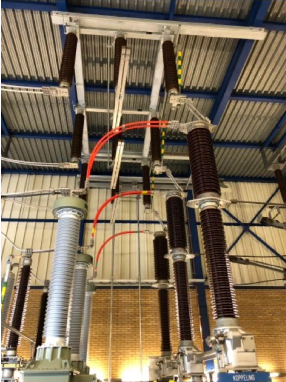
Foto 1: Aangebrachte flexibele noodgeleiders RTW wit gestoord.
