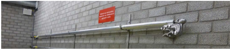
Figuur 1: Voorbeeld van een stokaarder op 380kV.
